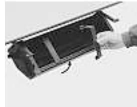
Die an den Kabelkästen befindlichen Klemmen, mit denen die Kabel im Kabelkasten fixiert sind, entfernen.
