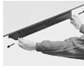
Der Kabelkasten wird geöffnet, indem Sie die zwei Knöpfe an den beiden Enden der Kabelrinne an der Ihnen zugewandten Seite gleichzeitig herausgezogen werden. Der Kabelkasten geht dann von selbst auf.
